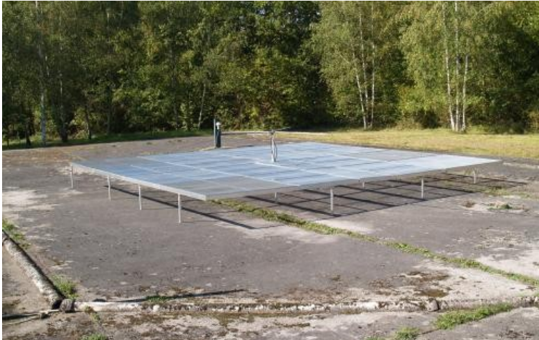
Abb. 10 Modifizierte GP Antenne der BRAMS Bake (Bild: [12])
