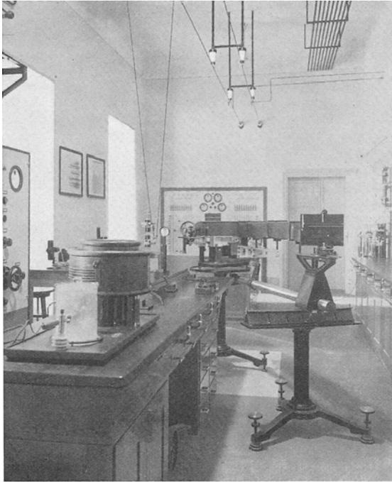
ABB. 3. Spektrographensaal 1934 mit STEINHEIL-Spektrograph GH mit langer Kamera
